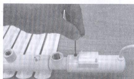
Отверните задний винт при помощи прилагаемого шестигранного ключа на 2 и сдвиньте блок термостата по горизонтали так, чтобы он закрыл резьбовой штуцер спирали. Затем поверните блок в поперечном направлении так, чтобы табло находилось на лицевой стороне, и заверните винт на задней стороне блока.
